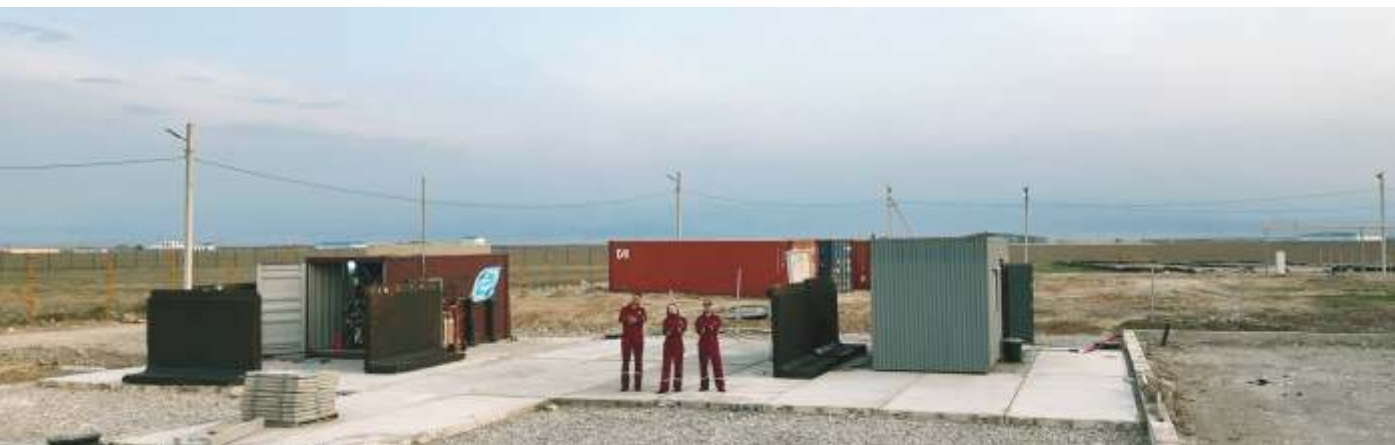
Общий вид промплощадки «Тяги»
