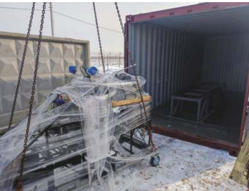
Монтаж испытательного стенда в контейнер
